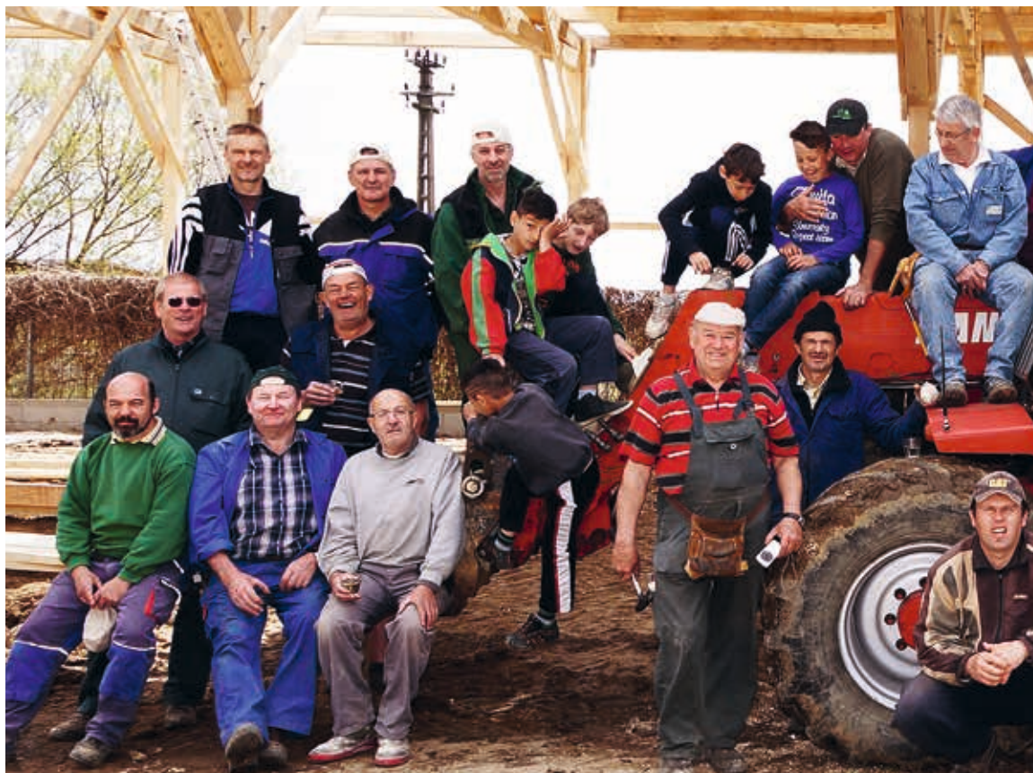
„Viele Hände, schnelles Ende“, das bewiesen 17 freiwillige Helfer aus Österreich im Rahmen und rumänischen Helfern eine neue Lagerhalle für Pellets in Saniob/Rumänien
